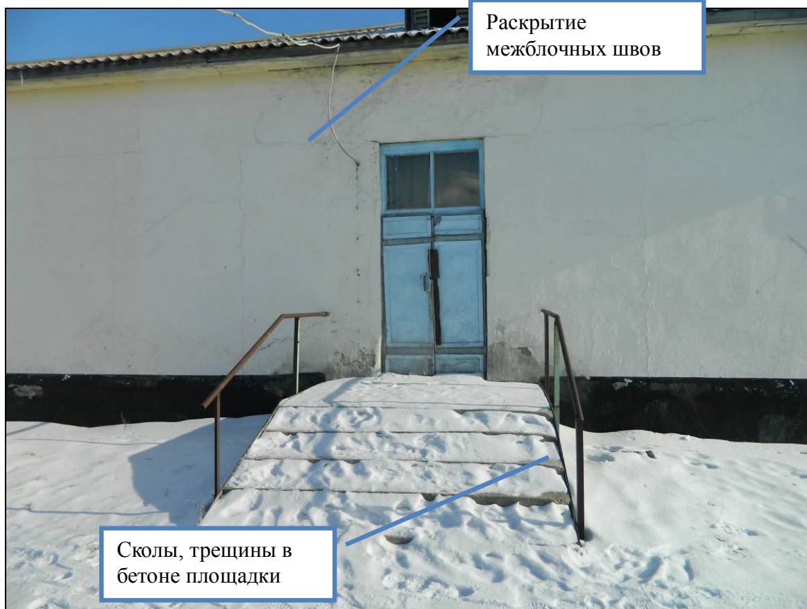
Рис. 11 Фрагмент фасада в осях «Ж-К»
