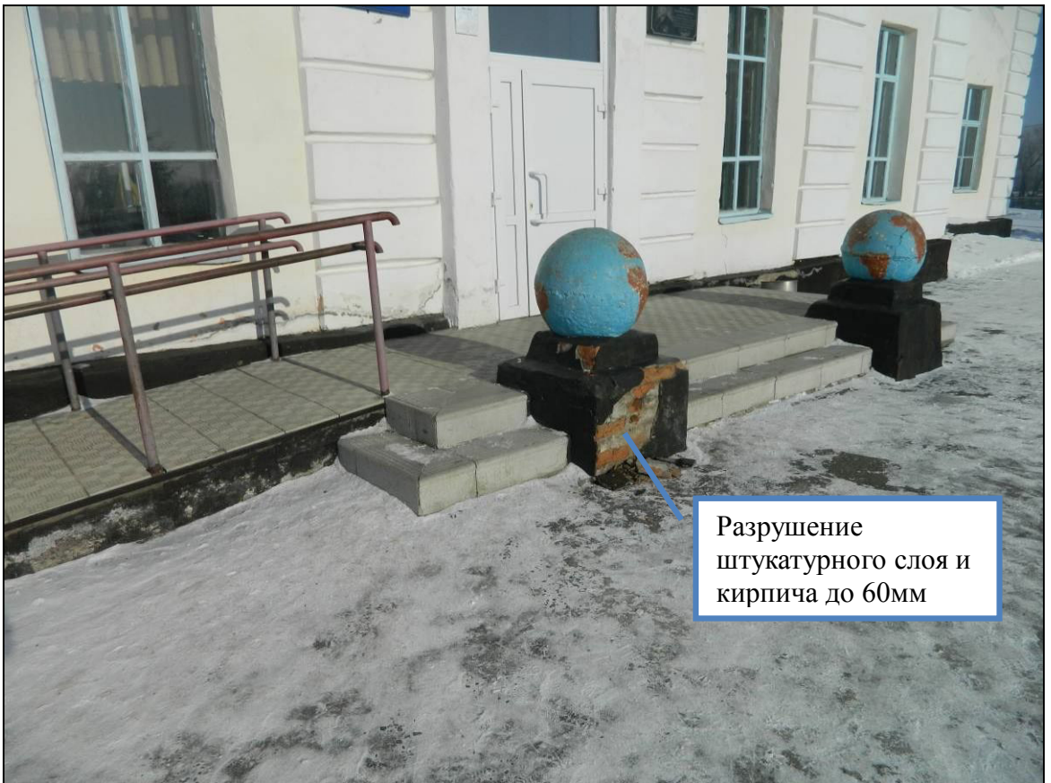
Рис. 28 Входной узел в осях «4-6/Н»
