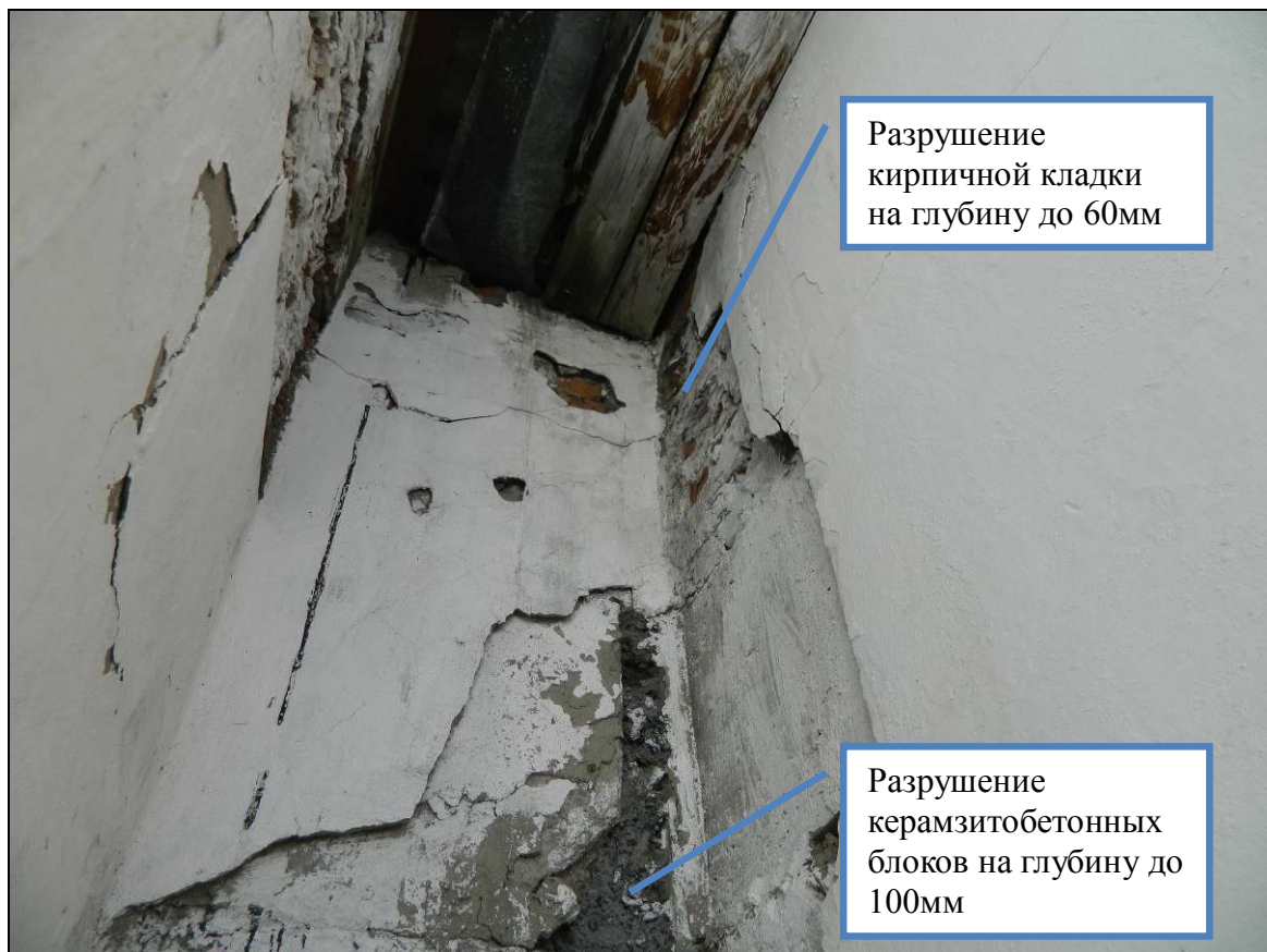
Рис. 13 Фрагмент фасада в осях «9-10»
