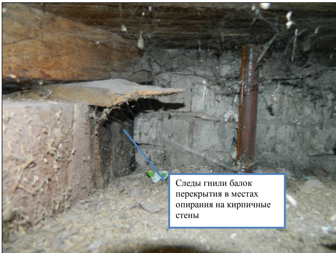
Рис. 18 Фрагмент балки междуэтажного перекрытия в осях «4-5/Д-Е»
