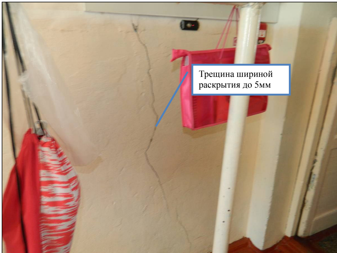
Рис. 9 Фрагмент перегородки в осях «5-6/Л-И»
