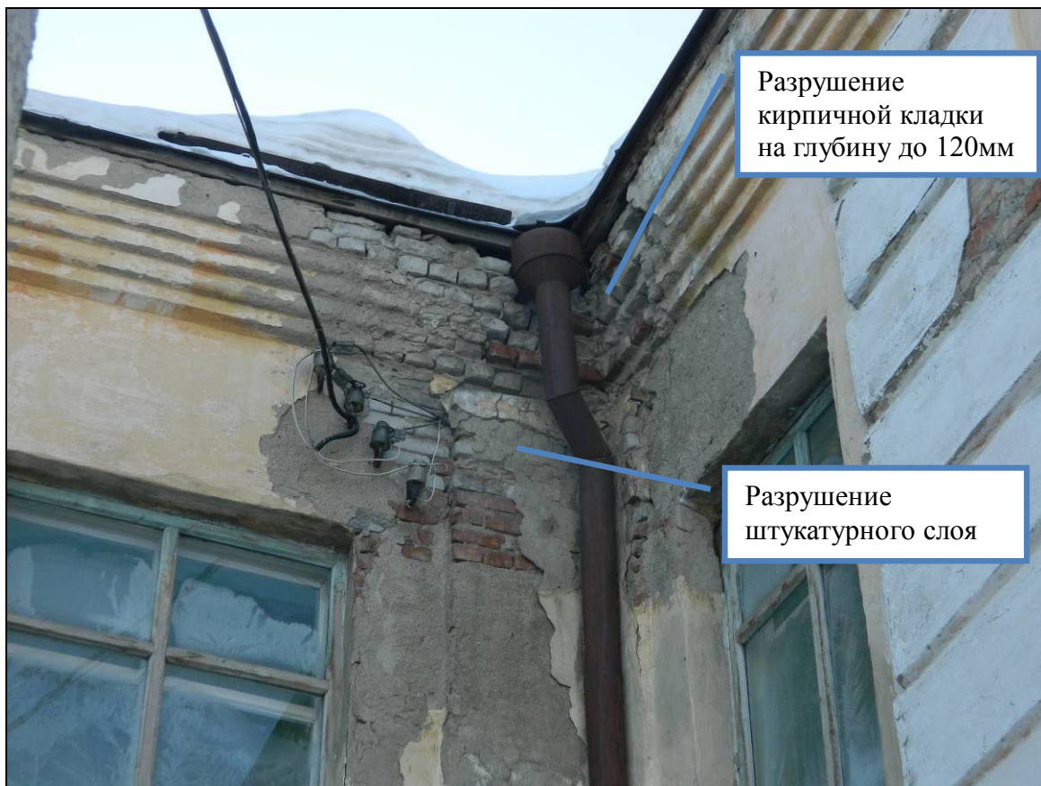
Рис. 7 Фрагмент фасада в осях «7/Д»
