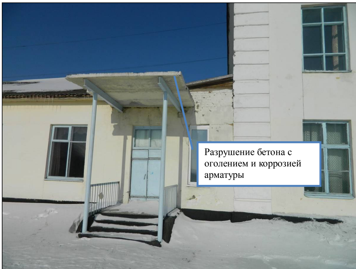
Рис. 33 Входной узел в осях «9-10/М»
