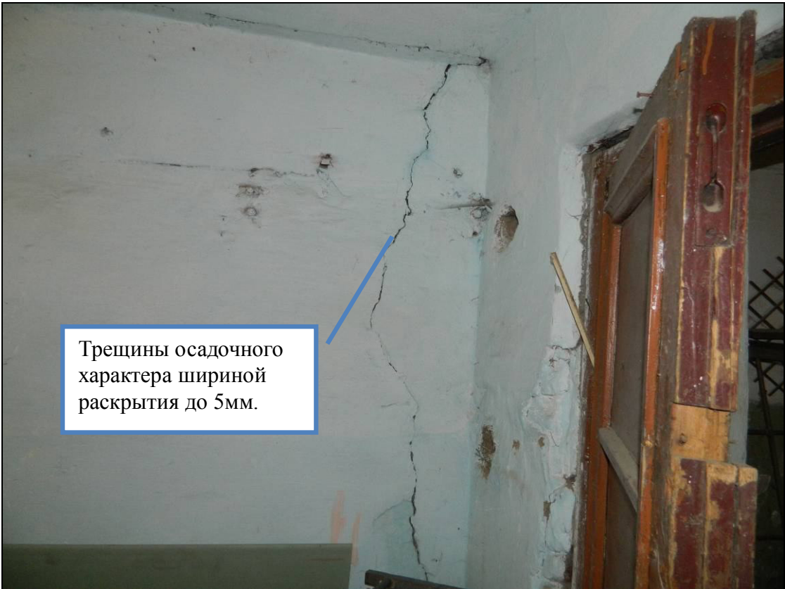
Рис. 1 Фрагмент стены подвала в осях «7/И»
