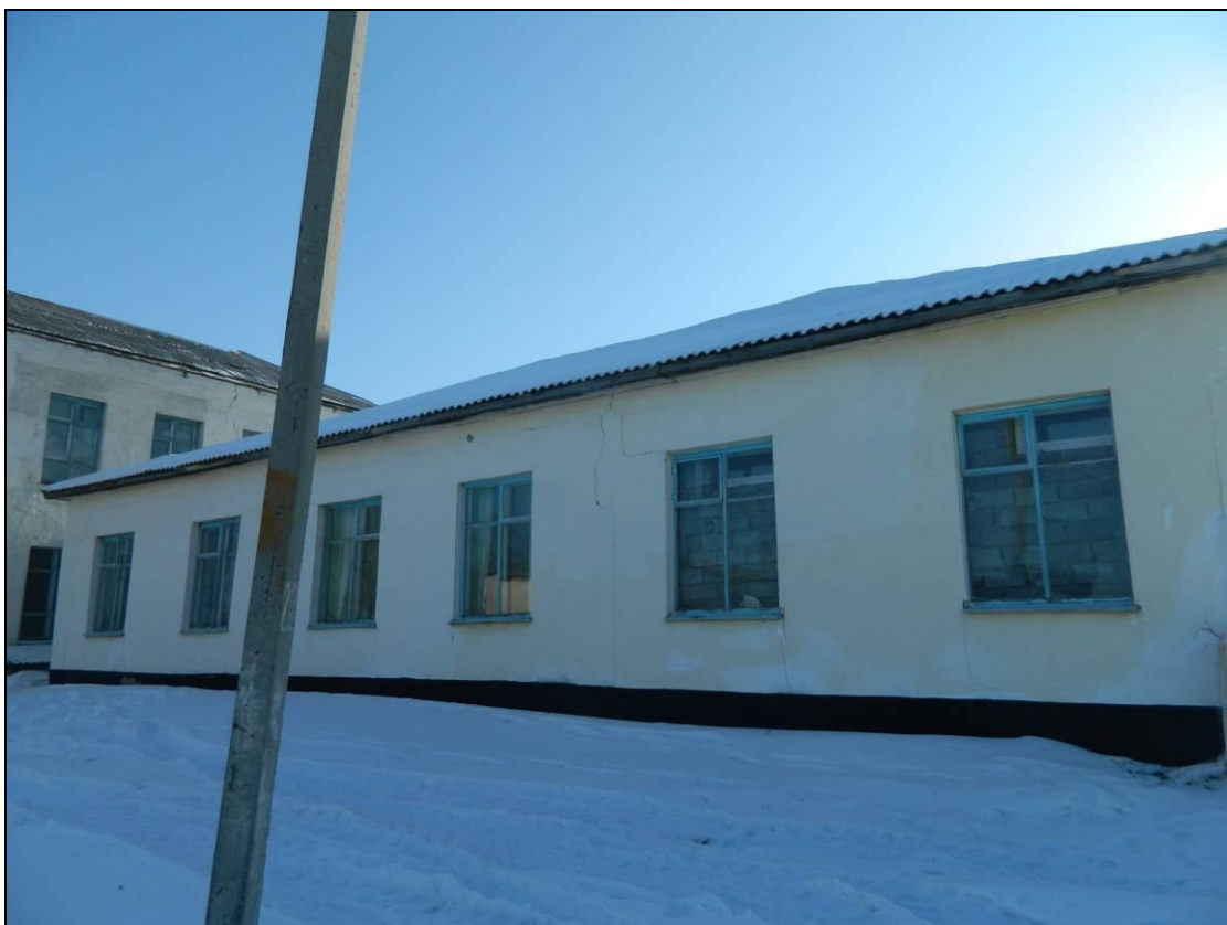
Фрагмент фасада блока №2 в осях «10-11»
