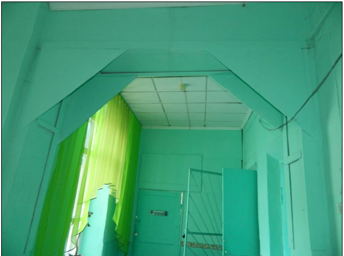
Рис. 36 Усиление проема на 2-м этаже по оси «Д» в осях «2-3»
