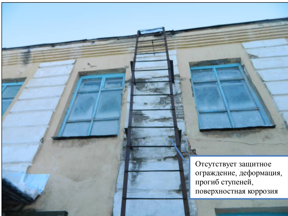
Рис. 30 Пожарная лестница в осях «5-7/Д»
