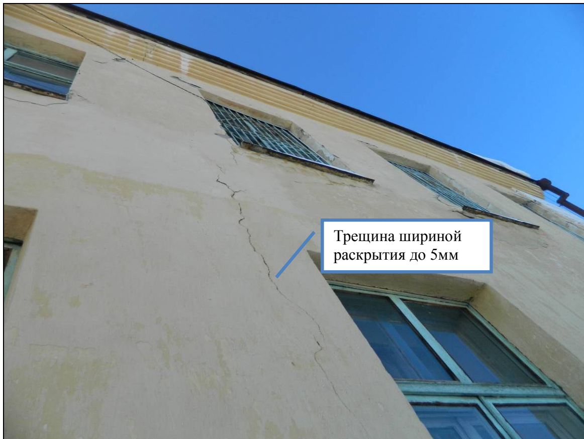
Рис. 5 Фрагмент фасада в осях «Д-Б»
