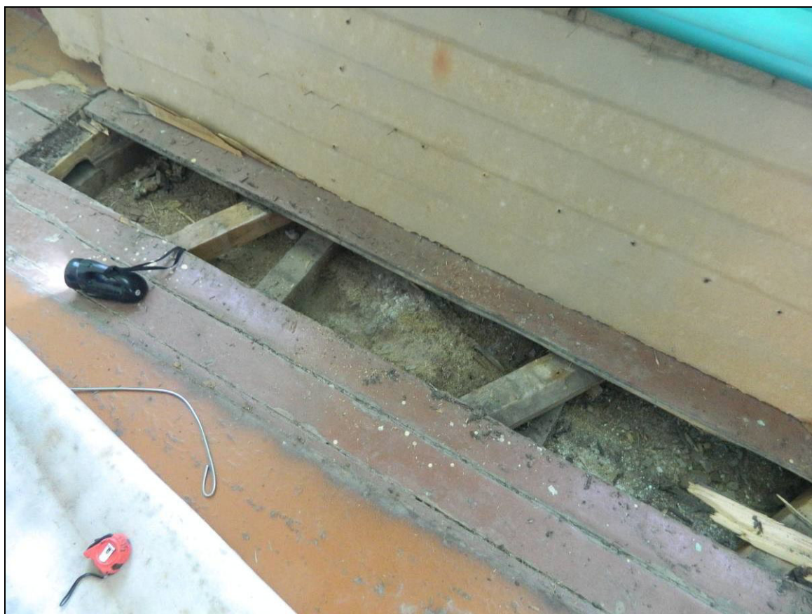
Рис. 16 Фрагмент вскрытия пола 2-го этажа в осях «4-5/Д-Е»
