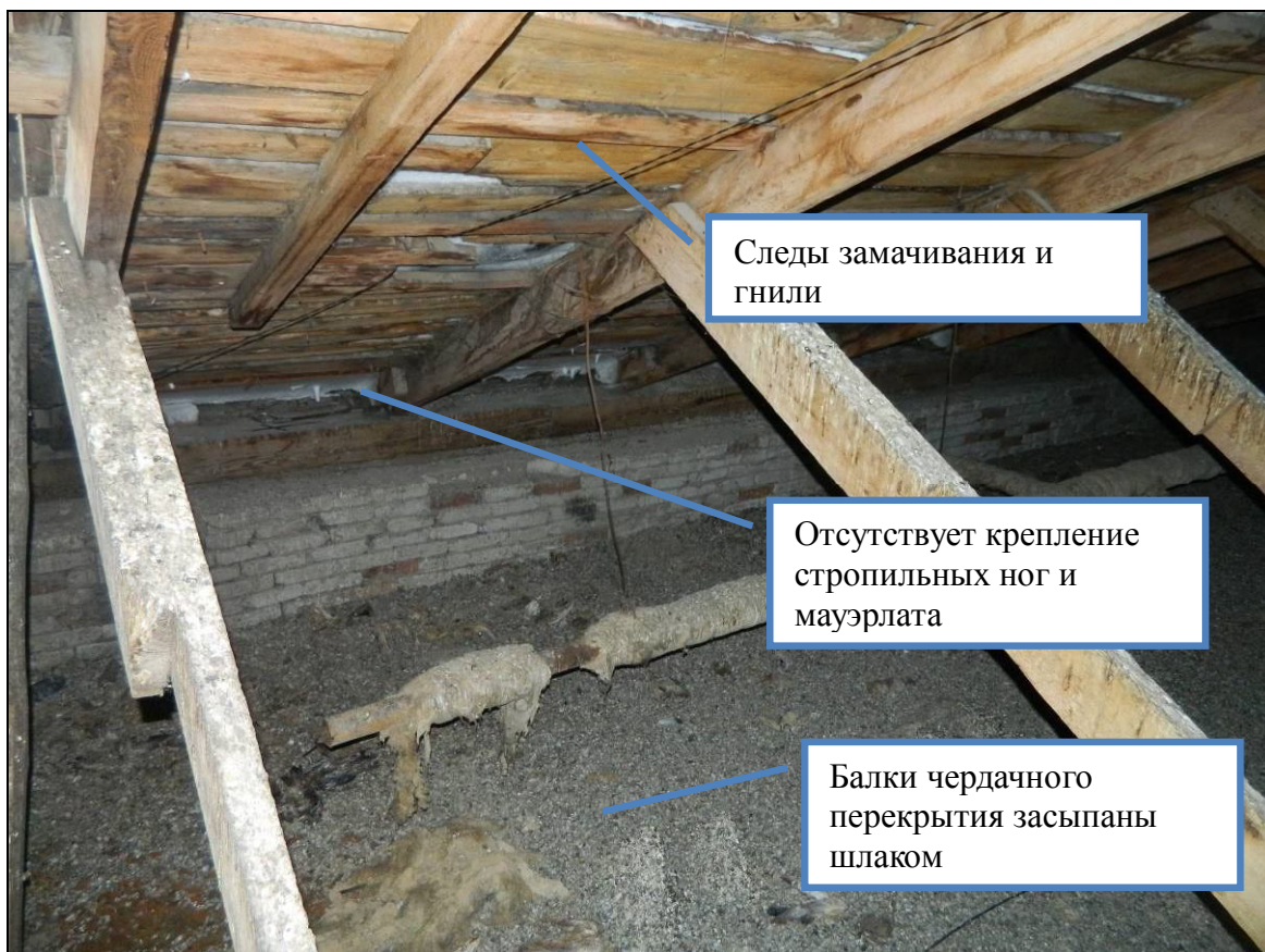
Рис. 24 Фрагмент стропильной системы в осях «3-5/Д-Е»
