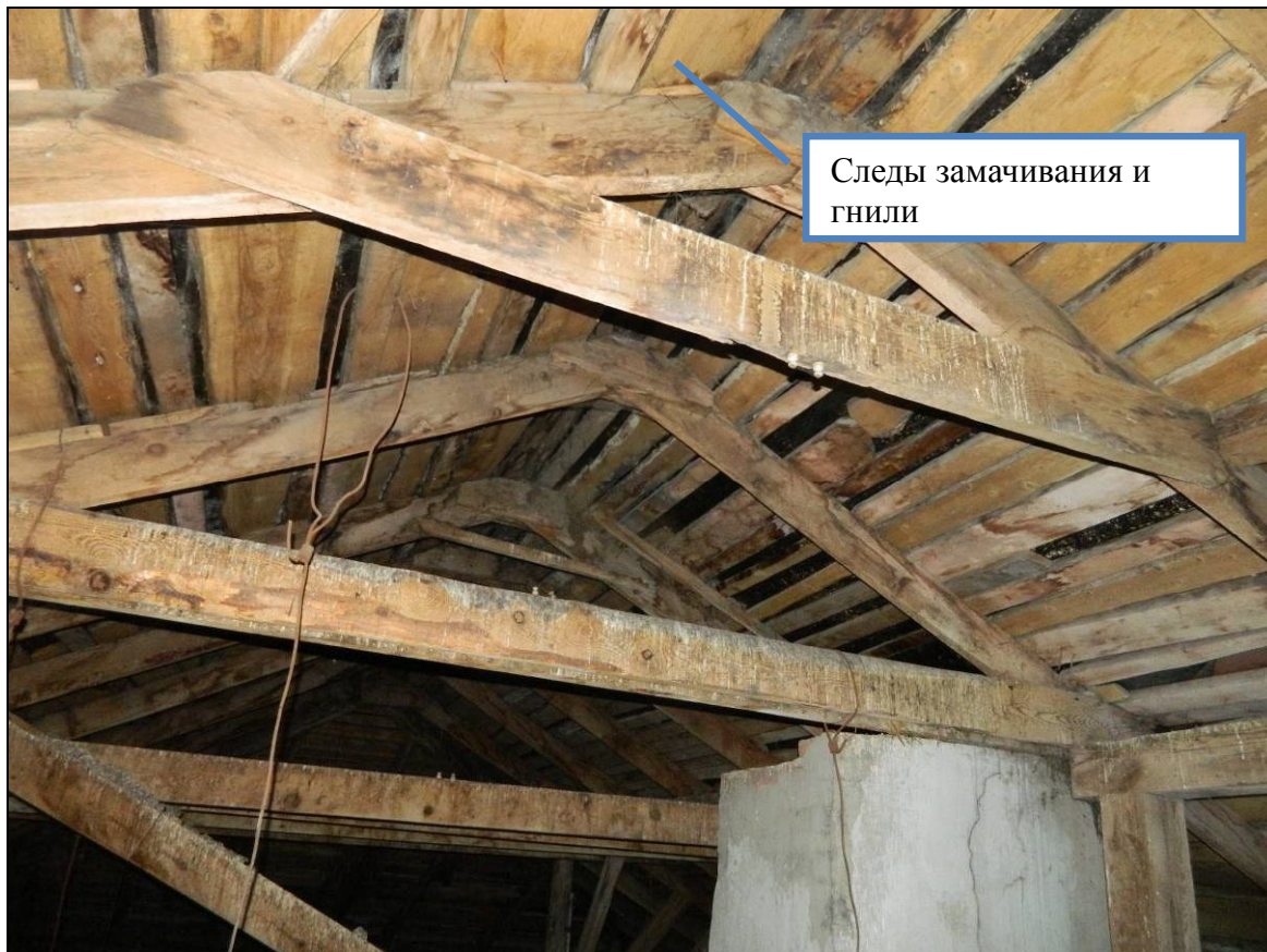
Рис. 23 Фрагмент стропильной системы в осях «7-9/Б-Д»
