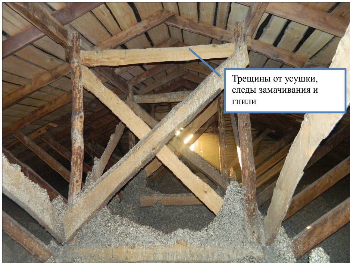
Рис. 25 Фрагмент стропильной системы в осях «10-11/Ж-К»
