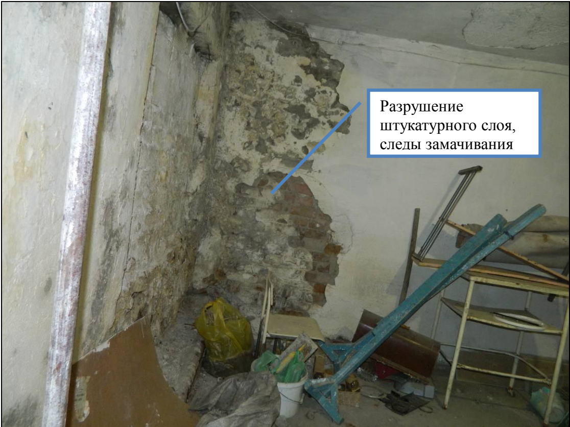
Рис. 2 Фрагмент стены подвала в осях «9/Д»
