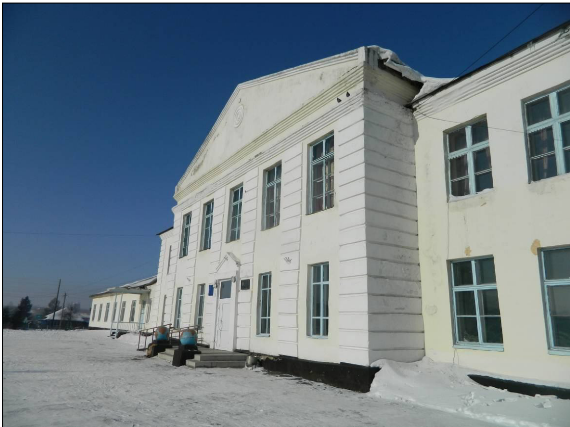
Фрагмент фасада блока №1 в осях «6-1»
