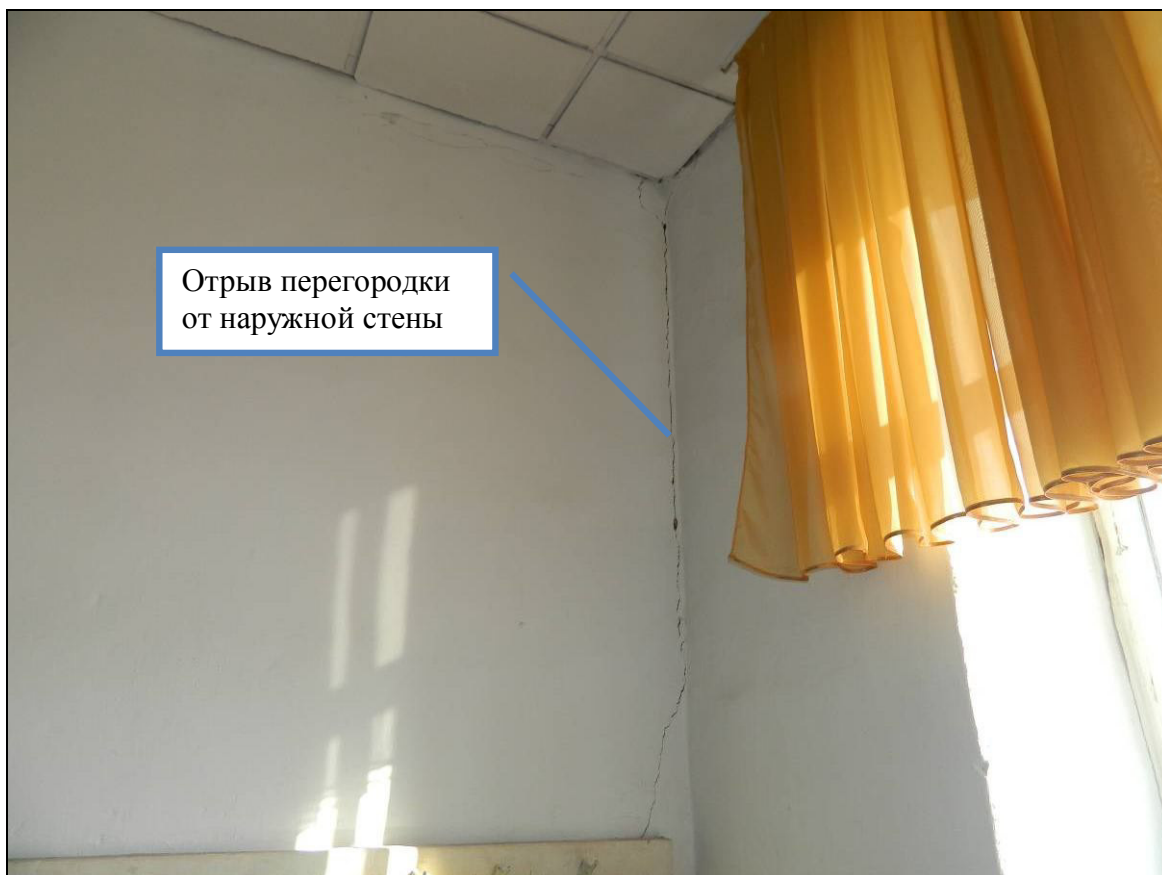
Рис. 10 Фрагмент перегородки в осях «4-5/Н»
