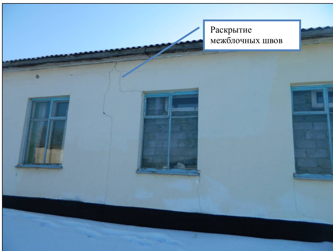
Рис. 12 Фрагмент фасада в осях «10-11»
