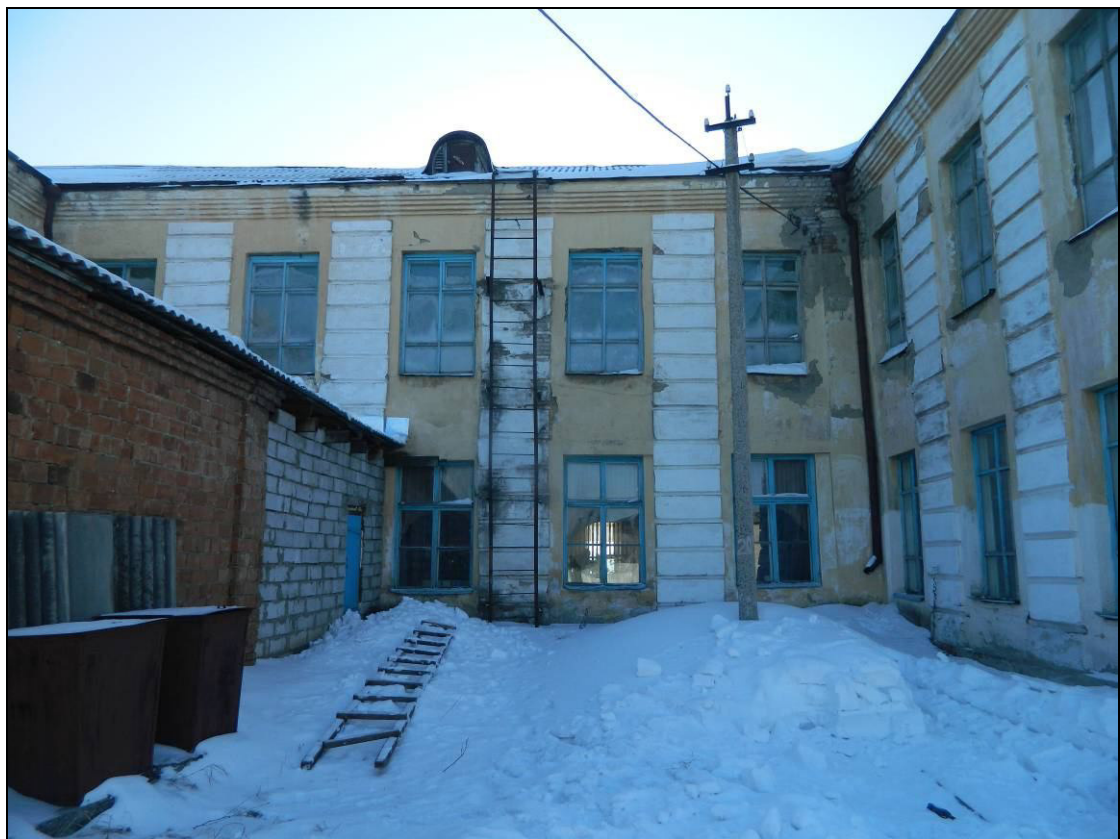
Фрагмент фасада блока №1 в осях «5-7»
