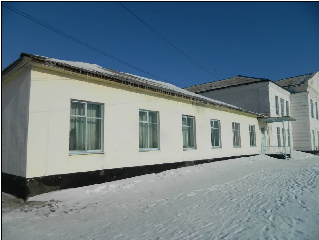
Фрагмент фасада блока №2 в осях «11-9»
