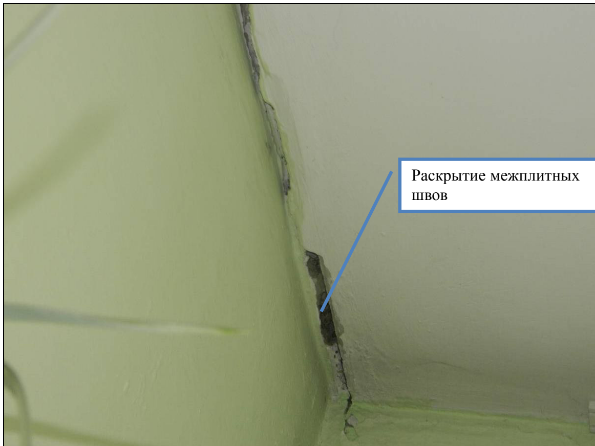
Рис. 19 Фрагмент чердачного перекрытия в осях «10-11/Г-Ж»
