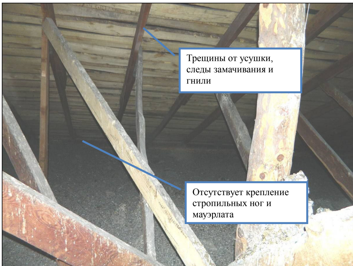
Рис. 26 Фрагмент стропильной системы в осях «10-11/Ж-Г»
