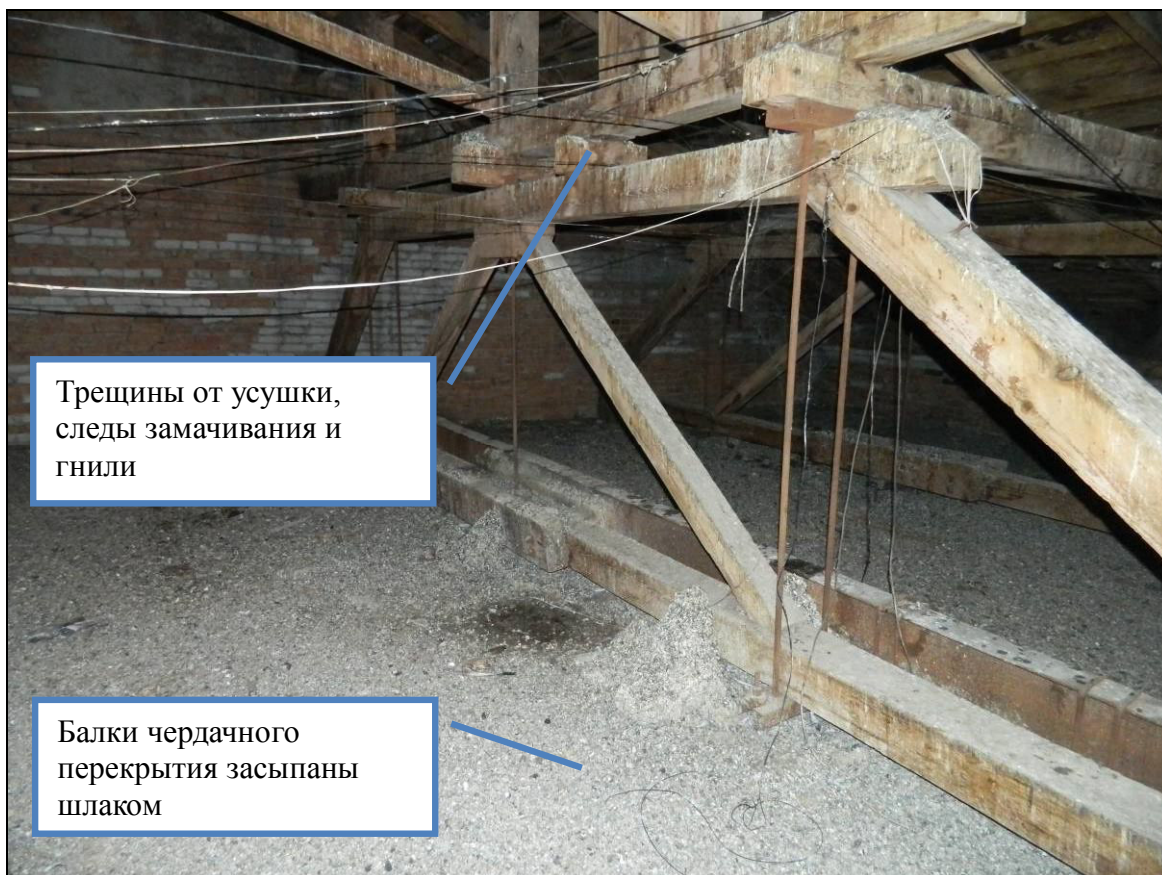
Рис. 22 Деревянная ферма в осях «4-6/И-Н»
